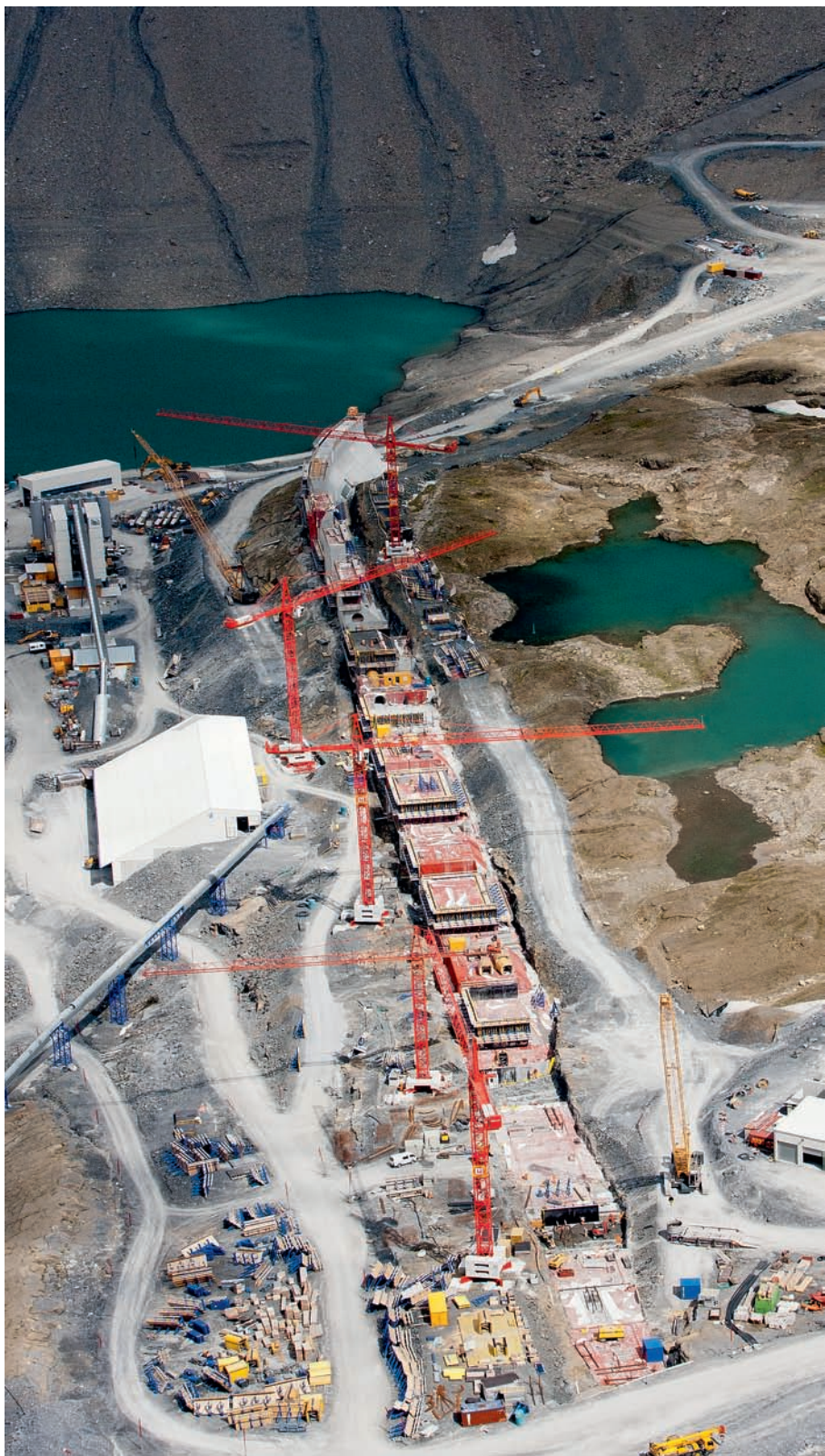
Limmern GL: Baustelle der neuen Pumpspeicheranlage im Sommer 2012
